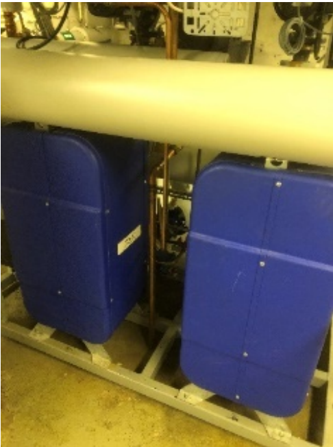
Värmeväxlarna för värmen.
