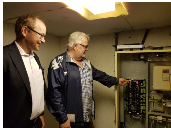
Peter Hallgren och Kent Thelin framför styrskåp till hiss. Här regleras bland annat till vilken våning hissen är kallad. Hit går larm om något skulle hända och talfunktion finns, om åkande skulle råka bli fast i hissen.
