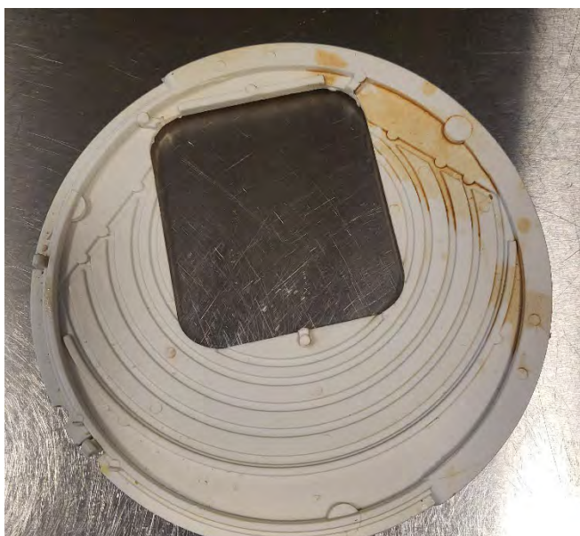
Strypbricka för justering av flöde i fläkten
