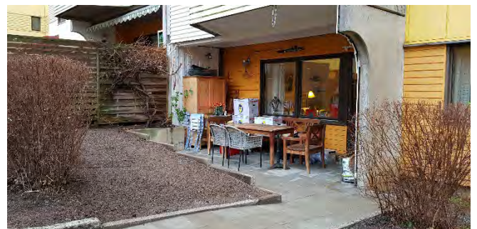
EFTER: Vattenläckan är lagad, allt är återställt till originalsckick. Uteplatsen är belagd med nya betongplattor, men trall, staket, och planteringar är borta.
