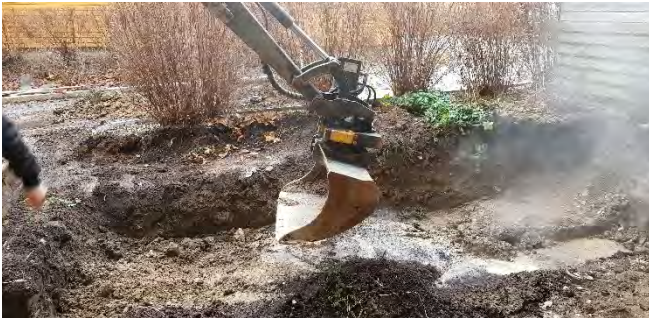
Både uteplats och mark grävdes upp.
