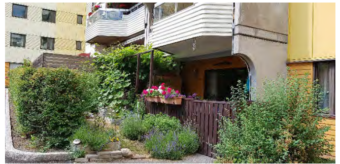
FÖRE: Så här såg det ut innan vattenläckan upptäcktes
