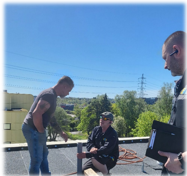
Ronny, Jörgen och Vladde under en inspektion av taken
